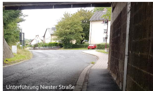
Unterführung Niester Straße
