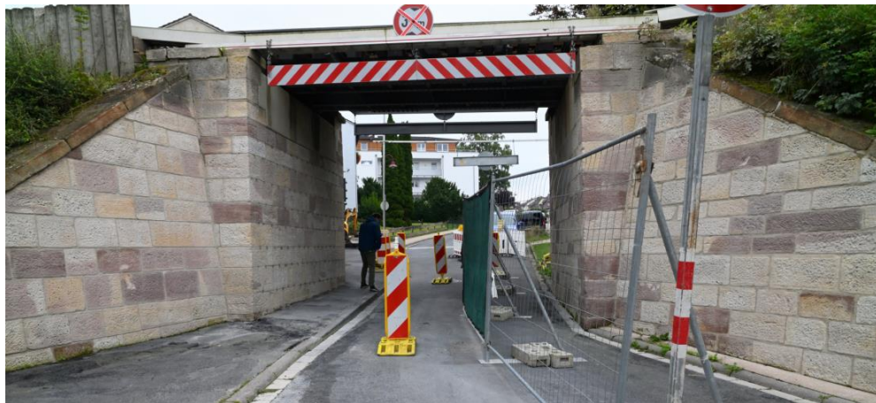
Abbildung 71: Unterführung Am Haferbach zur Zeit der Baustelle
