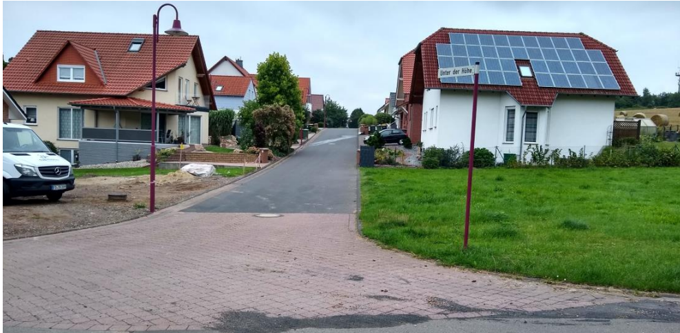
Abbildung 54: Asphaltierte Fahrbahn in Unter der Höhe
