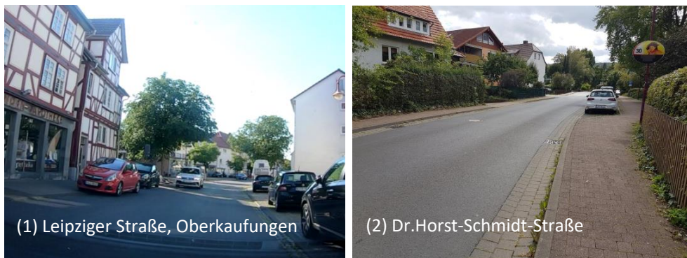
Abbildung 42: Eindrücke entlang der Trassenalternativen auf Abschnitt 3
