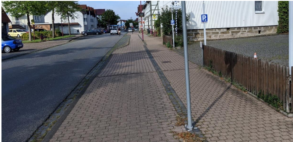
Abbildung 48: Gehweg mit Pflasterstreifen Leipziger Straße Niederkaufungen
