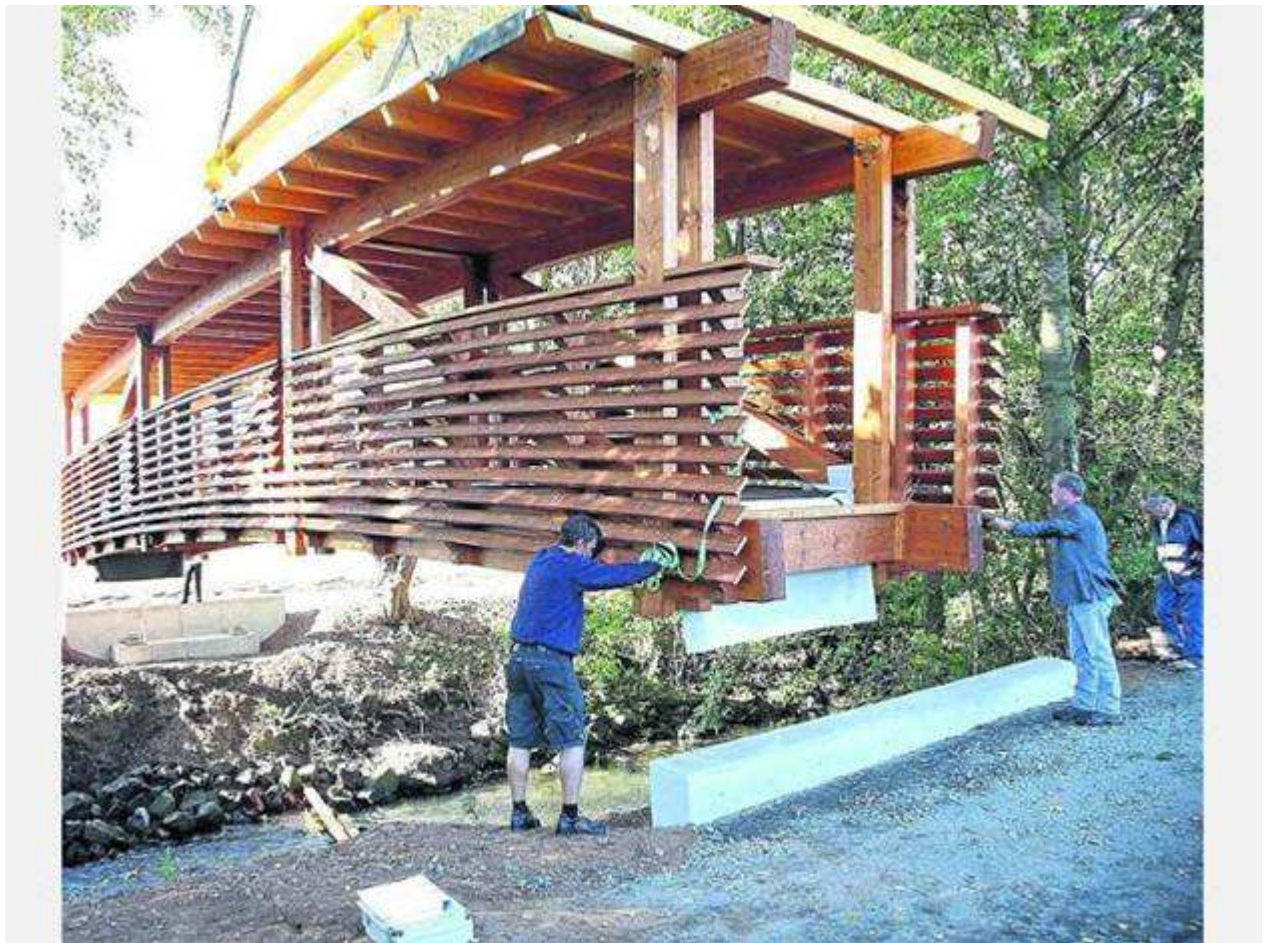
Foto: Brücke Rehheckenweg
